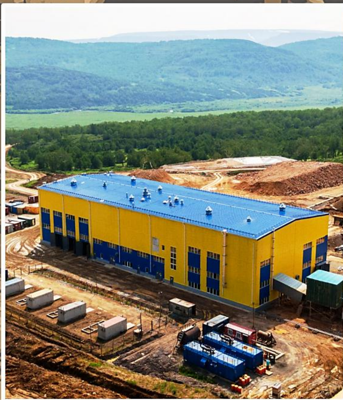
Золотоизвлекательная фабрика Озерновского ГК в стадии завершения строительства
