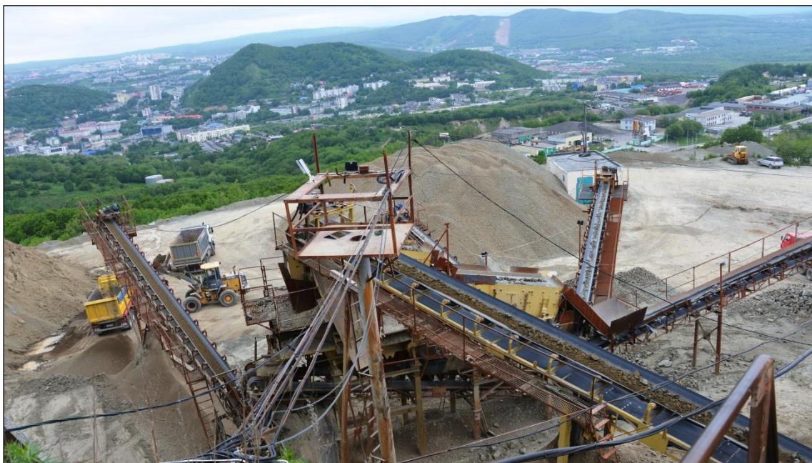
Дробильно-сортировочная установка в карьере на Петровской сопке
