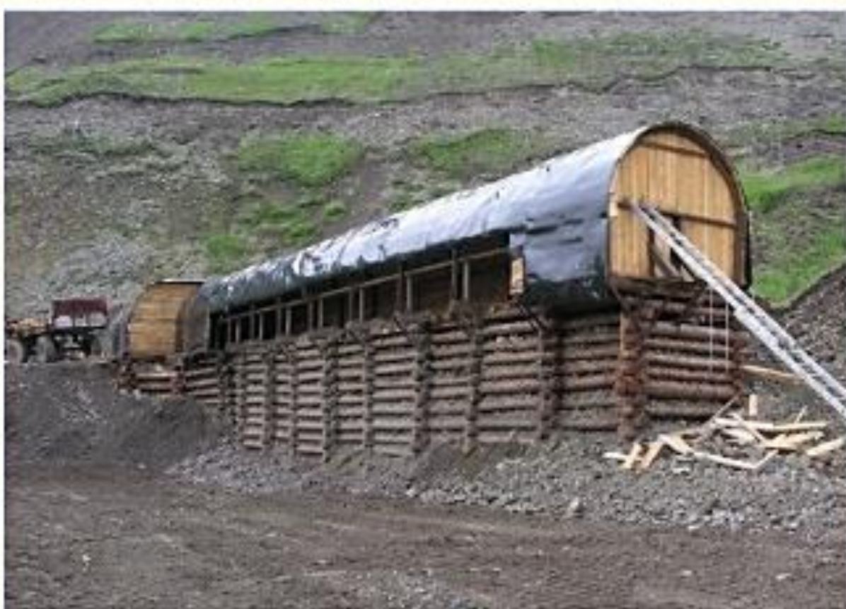
Новая отвальная эстакада шлюзы № 5
