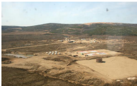
Стройплощадка и вахтовый поселок Аметистового ГОК
