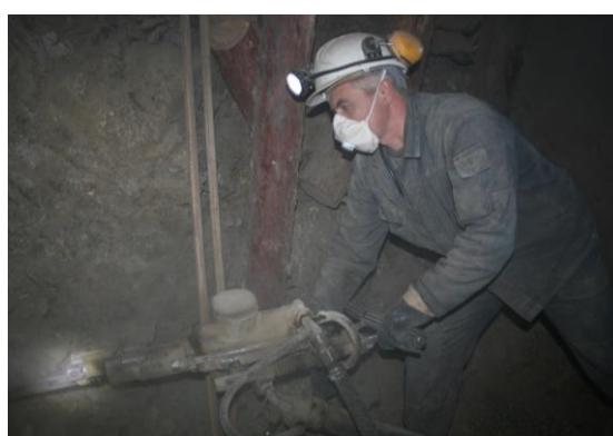
Бурение шпуров в слоевом штреке
