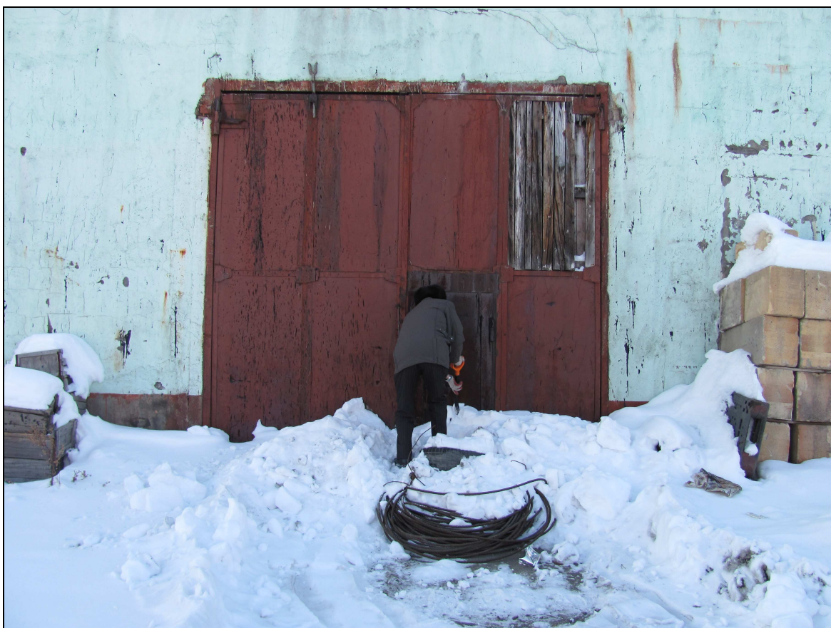
Рис. 7 Вход в камнехранилище на 12 км Елизовского шоссе.
